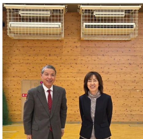
完成した木津中学校体育館のエアコン
