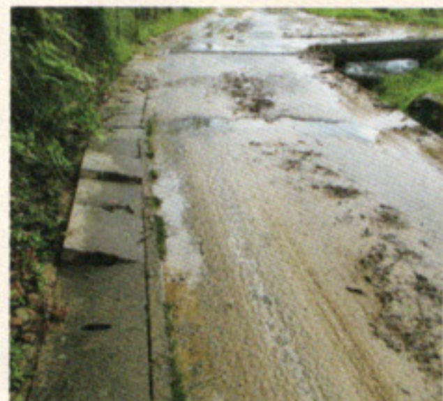
市原篠坂 土砂撤去と側溝の掃除
