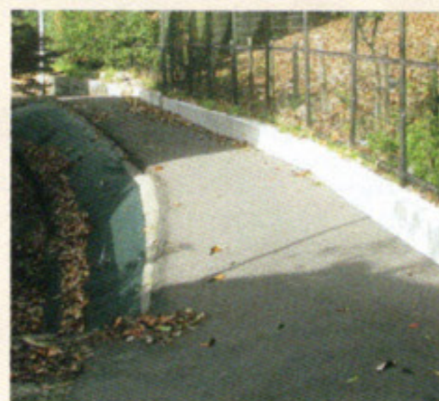
修学院横山 道路と側溝の崩れを改修
