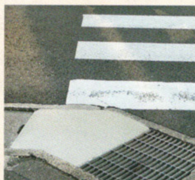
岩倉中信前 側溝フタの改修
