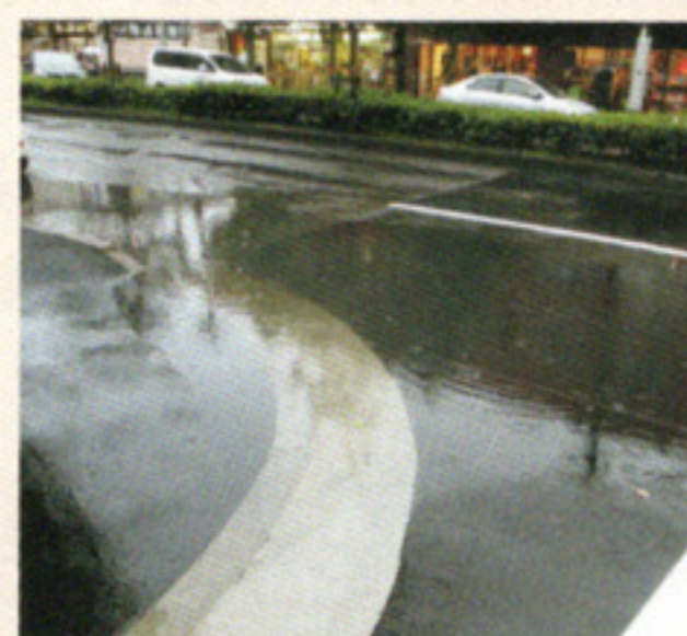
修学院駅前 側溝のつまり解消
