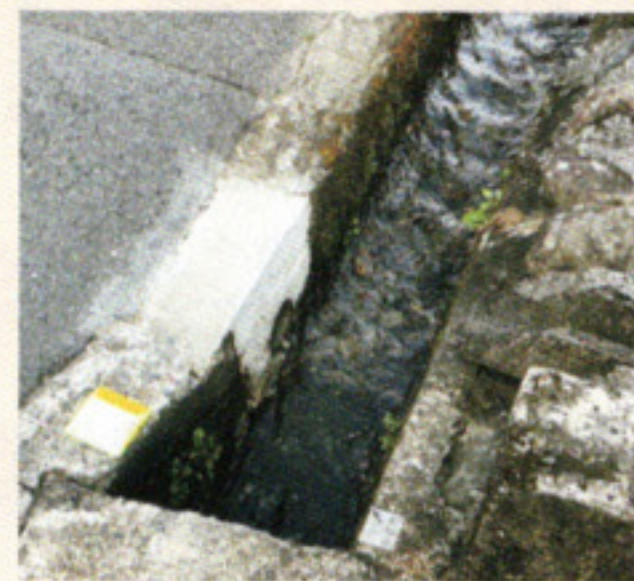
上高野下荒時町 道路補修
