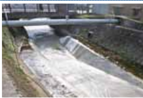
河床掘下工事が完了(四宮川「沢橋」上流)
