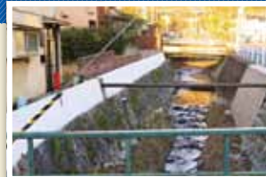
護岸コンクリート補強(安祥寺川)
