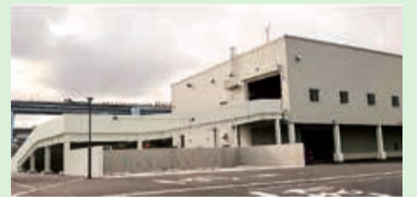
八幡市内で回収したごみを中継施設に集め、大型パッカー車で処理施設に運びます。
