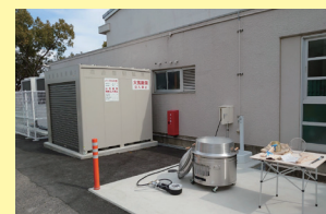
くすのき小学校・炊き出し設備
