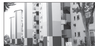
男山団地のエレベーター設置
