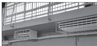
学校体育館へのエアコン設置
