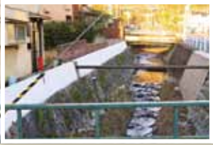
護岸コンクリート補強(安祥寺川)
