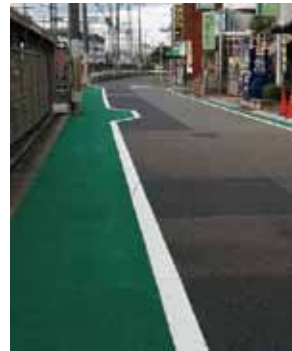
カラー舗装の歩道ができました
