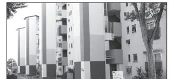
男山団地のエレベーター設置
