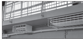
学校体育館へのエアコン設置
