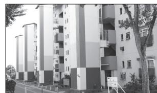
男山団地のエレベーター設置
