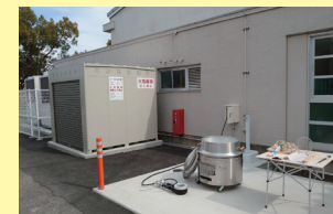
くすのき小学校・炊き出し設備
