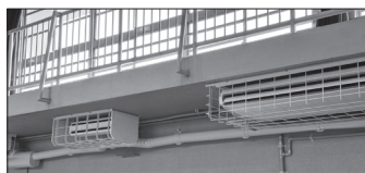
学校体育館へのエアコン設置
