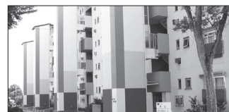
男山団地のエレベーター設置
