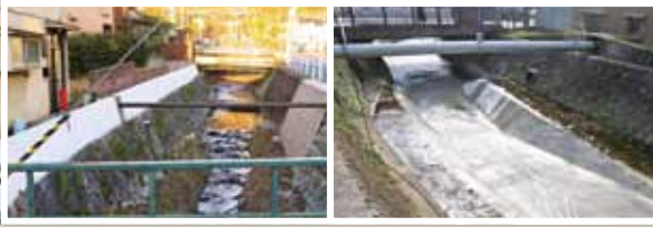
護岸コンクリート補強(安祥寺川)
