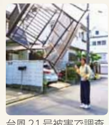
台風21号被害で調査
